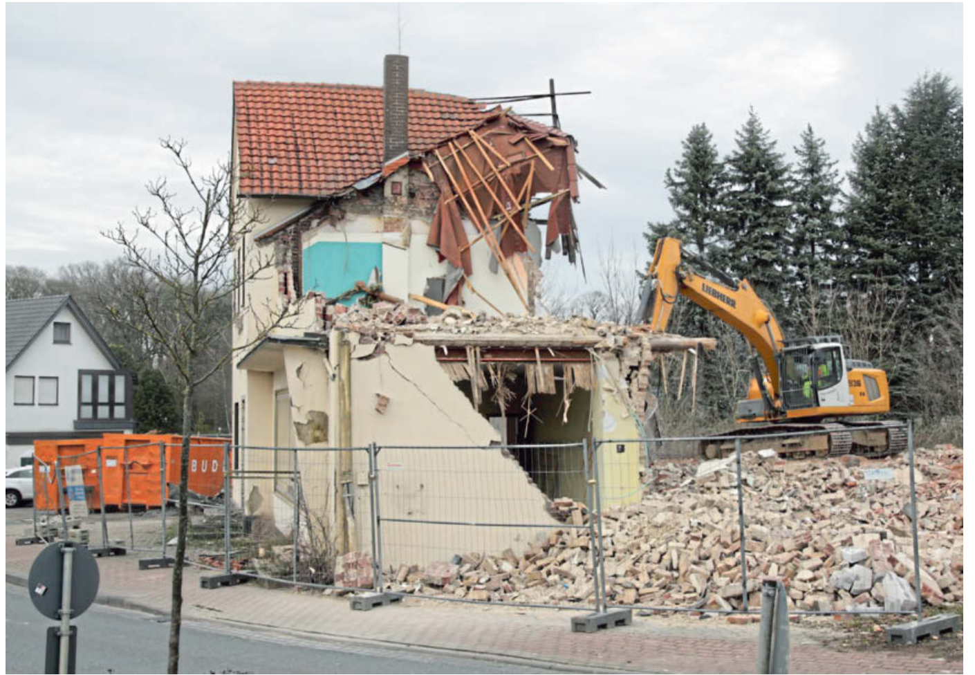
Als dieses Foto am Montag entstand, war das Gebäude bereits zum größten Teil abgerissen.
