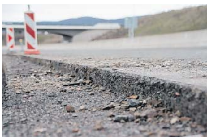
Die letzte Schicht kann kommen: Die Nordumgehung ist – wie hier in Eidinghausen – auf den offenporigen Asphalt vorbereitet. Im Sommer soll diese Deckschicht aufgebracht werden. FOTO: JOHANNES WÖPKEMEIER
