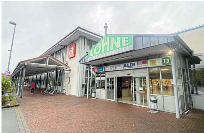
Der alte Gebäudekomplex soll abgerissen werden. Foto: Windmüller
